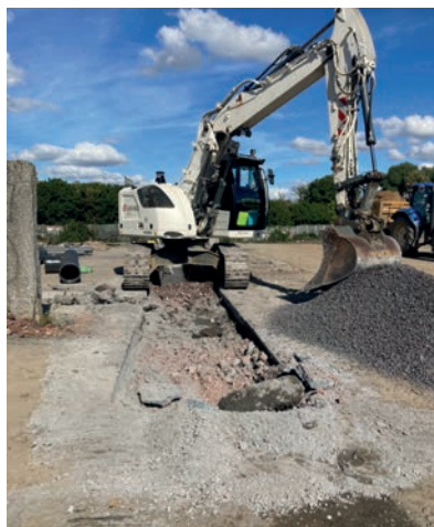
Remblais d'infrastructures d'assainissement réalisés avec des graves non traitées
