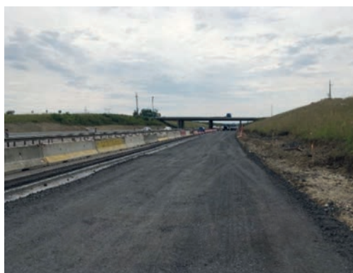
Couche de réglage de la couche de forme : 23 000 tonnes de laitier de haut-fourneau de granulométrie 0/31,5 mm
