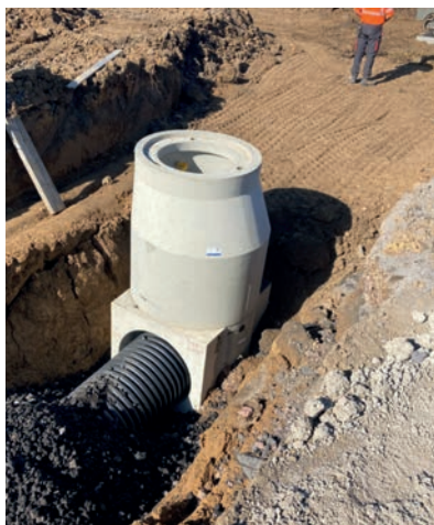
Remblais d'infrastructures d'assainissement réalisés avec des graves non traitées
