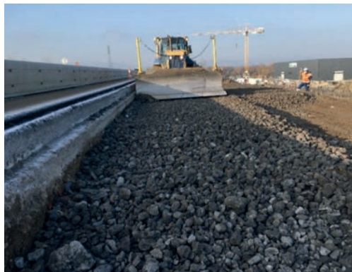
Partie supérieure des terrassements (PST) : 42 500 tonnes de laitier de haut-fourneau de granulométrie 0/100 mm
