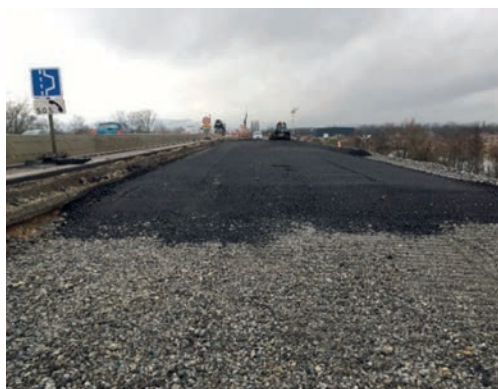
Couche de forme : 51 500 tonnes de laitiers d'aciérie de four électrique de granulométrie 0/63 mm et 0/31,5 mm
