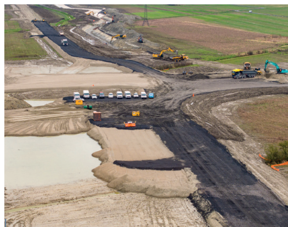
Aménagement des futures voies d'accès au Gigafactory au sein du Grand Port de Dunkerque
